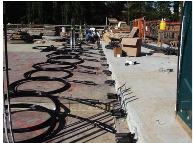
Fig. 5 – Coupling Tendons in a Continuation Slab Pour
